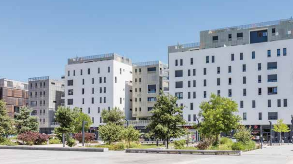
▲ Le Carré de la Maourine accueille logements, commerces, bureaux et métro.
