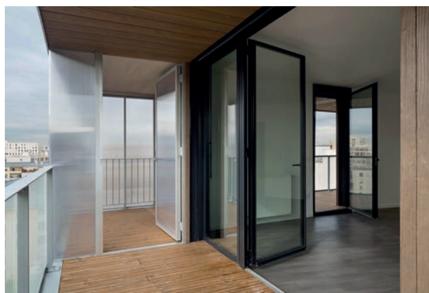
Réf. : Résidence de l'aqueduc, Gentilly, Daquin et Ferrière Des jardins d'hiver sont glissés entre les balcons, offrant un espace supplémentaire aux habitants pour bricoler, jardiner, recevoir son voisin...
