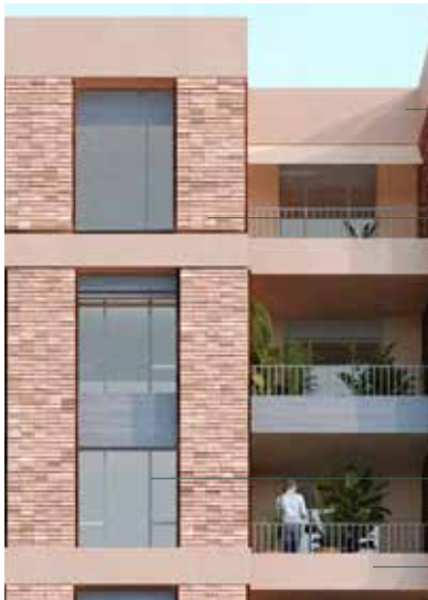
LA FAÇADE VERTICALE
